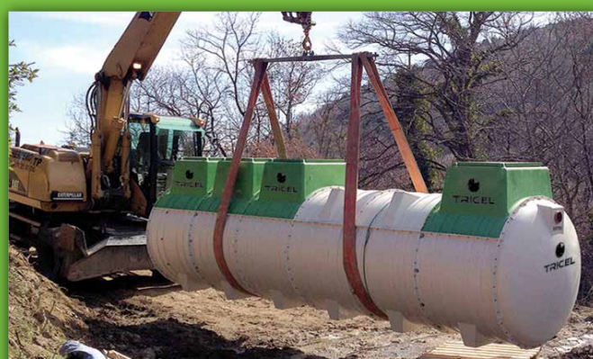
Installation d'une Tricel Novo FR20
